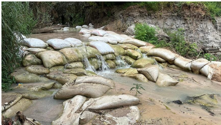
Aufstauen des Flussbetts mit bepflanzten Erdsäcken
