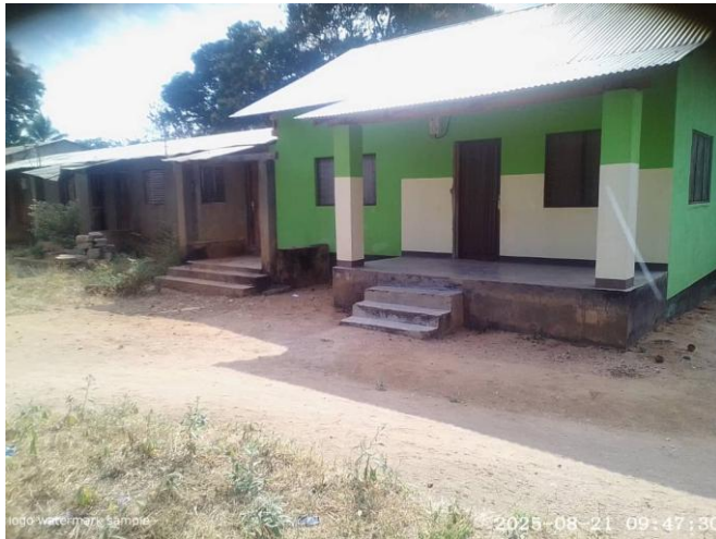
rechts das renovierte vergrößerte Haus, links das noch zu renovierende Haus
